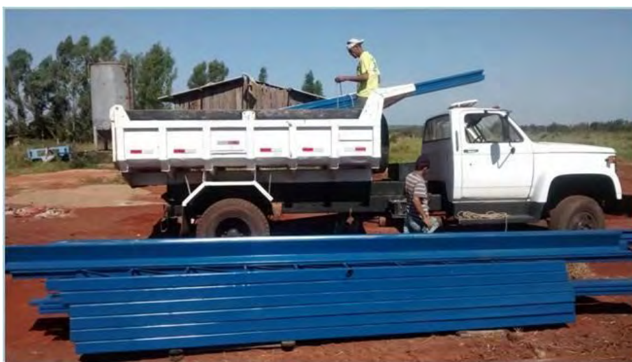
Figura 2. Construção de Centro Comunitário em assentamento. (Fonte: FIBRIA, Relatório Destaques MS 2015)
