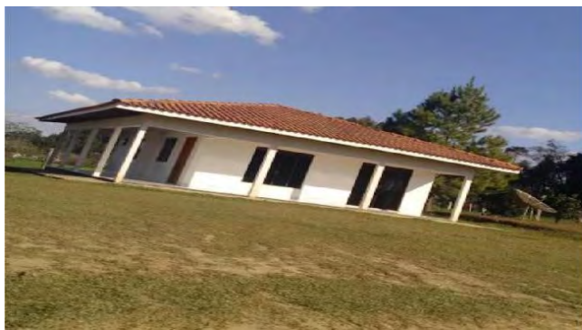
Fotografia 6. Casa de morador em 2016
