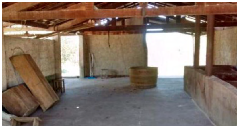
Figura 4. Farinheira em reforma - Raizama. Fonte: Monlevade (2016)
