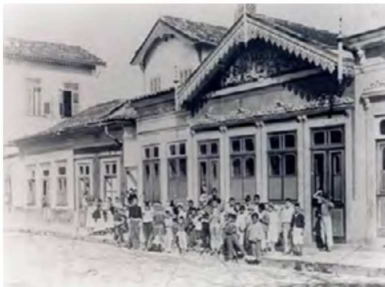
Imagem 6. Prédio da Rua Frei Caneca. Foto de Augusto Malta, 1906 Fonte: Arquivo Geral da Cidade do Rio de Janeiro (AGCRJ).
