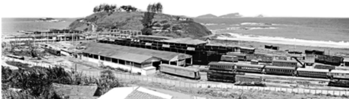
Figura 1 - Instalações das Oficinas de Imbetiba já em decadência no final dos anos 1970 - Acervo particular de Luiz Cláudio Bittencourt
