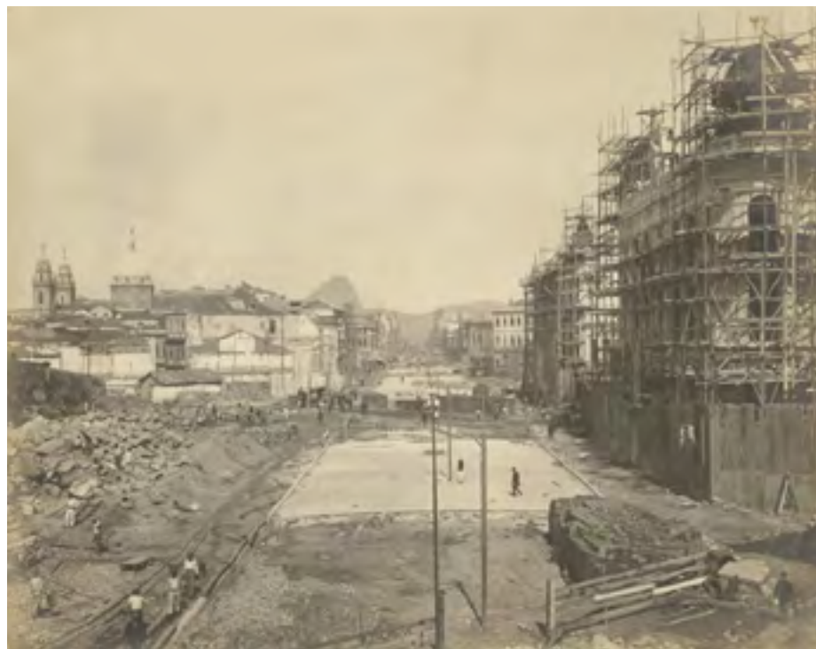
Imagem 2. Avenida Central: vista panorâmica durante os trabalhos de pavimentação - Augusto Malta - 09/1905 - Fonte: Brasiliana Fotográfica.
