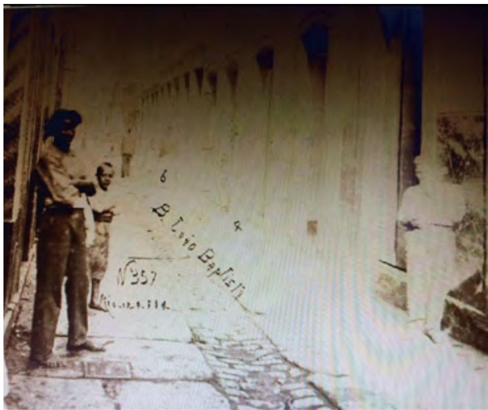
Imagem 1. Beco João Batista – Augusto Malta – 1904. Fonte : MIS – RJ.
