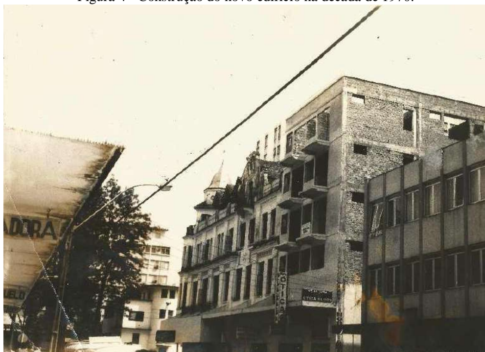
Figura 4 - Construção do novo edifício na década de 1970.
