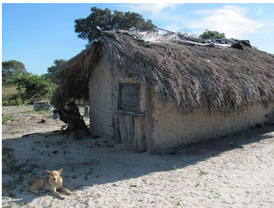
Figura 1 – Residência situada na extensão territorial do município de Bonito de Minas/MG
