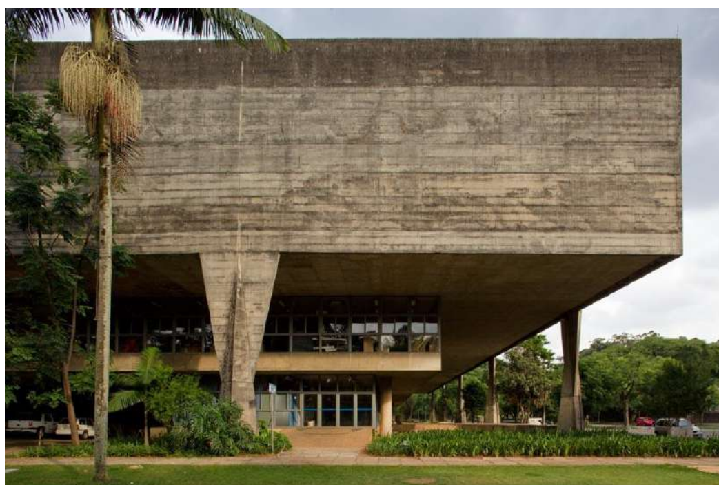
Figura 4: Faculdade de Arquitetura e Urbanismo / USP, Arquiteto Vilanova Artigas, 1961/1968. (Imagem: Nelson Kon)
