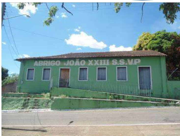
Figura 15: Abrigo João XXIII – Fachada Sul. Fonte: Suyanne Paranhos Matos, 2013.
